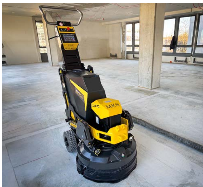
Die Schleifmaschine MKS High Tech 680 RC Ultra bereitete den Estrich auf rund 11.000 m 2 in einem Arbeitsgang für die Verlegung von Teppichfliesen vor.
